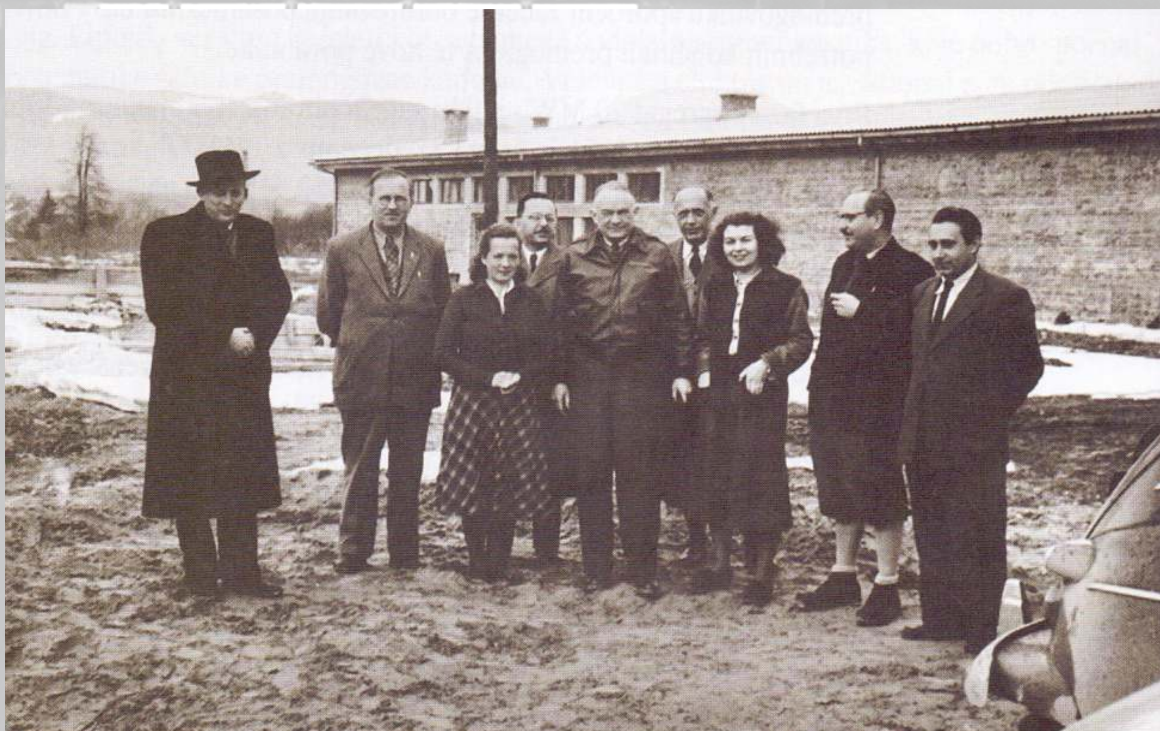
Člani prve investicijske skupine za gradnjo TE Velenje II in nekaj gostov na gradbišču, okoli 1950
