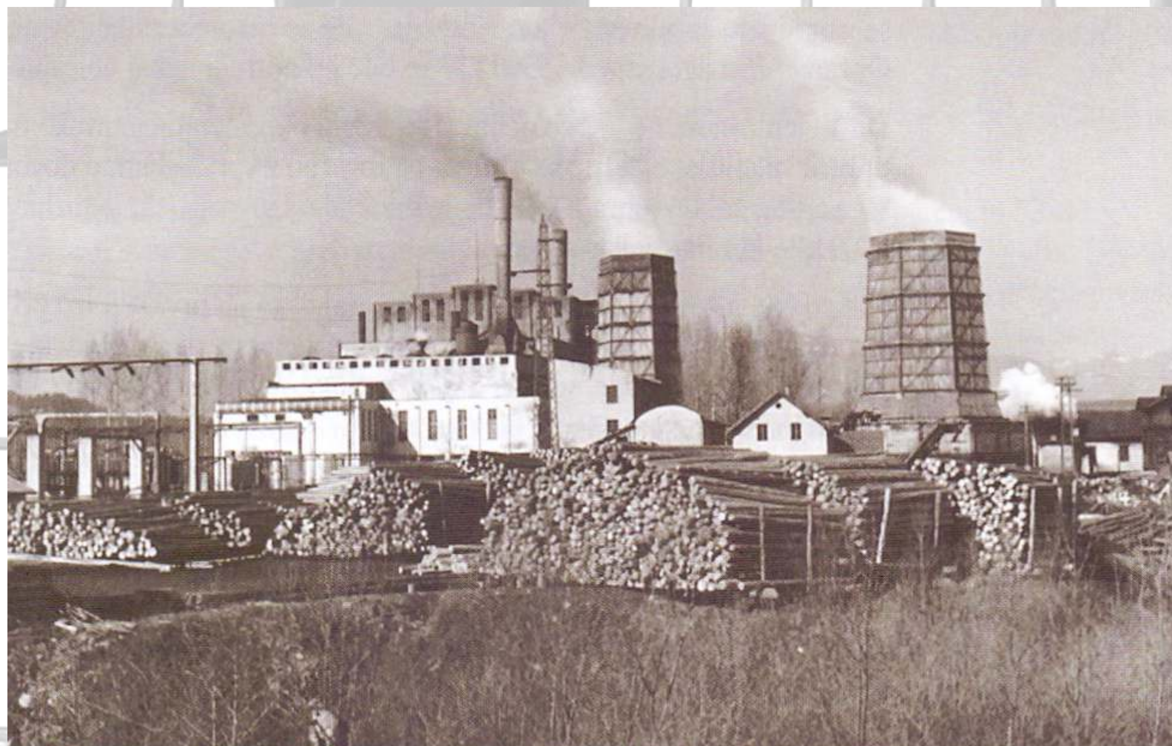
Pogled na elektrarno z vzhodne strani, okoli 1950
