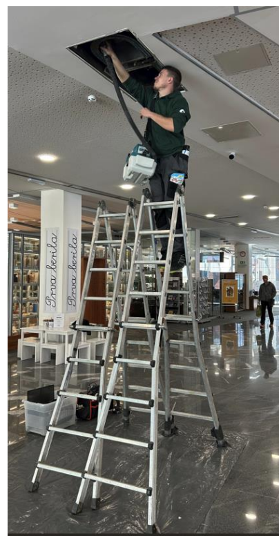
Čiščenje prezračevalnega sistema
