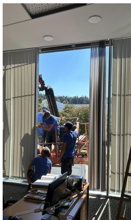
Montaža novega okna
