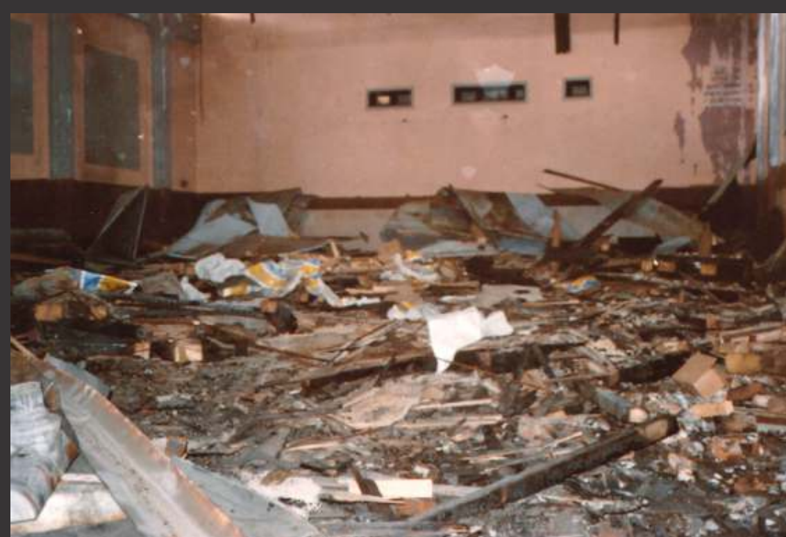
Dvorana po požaru
