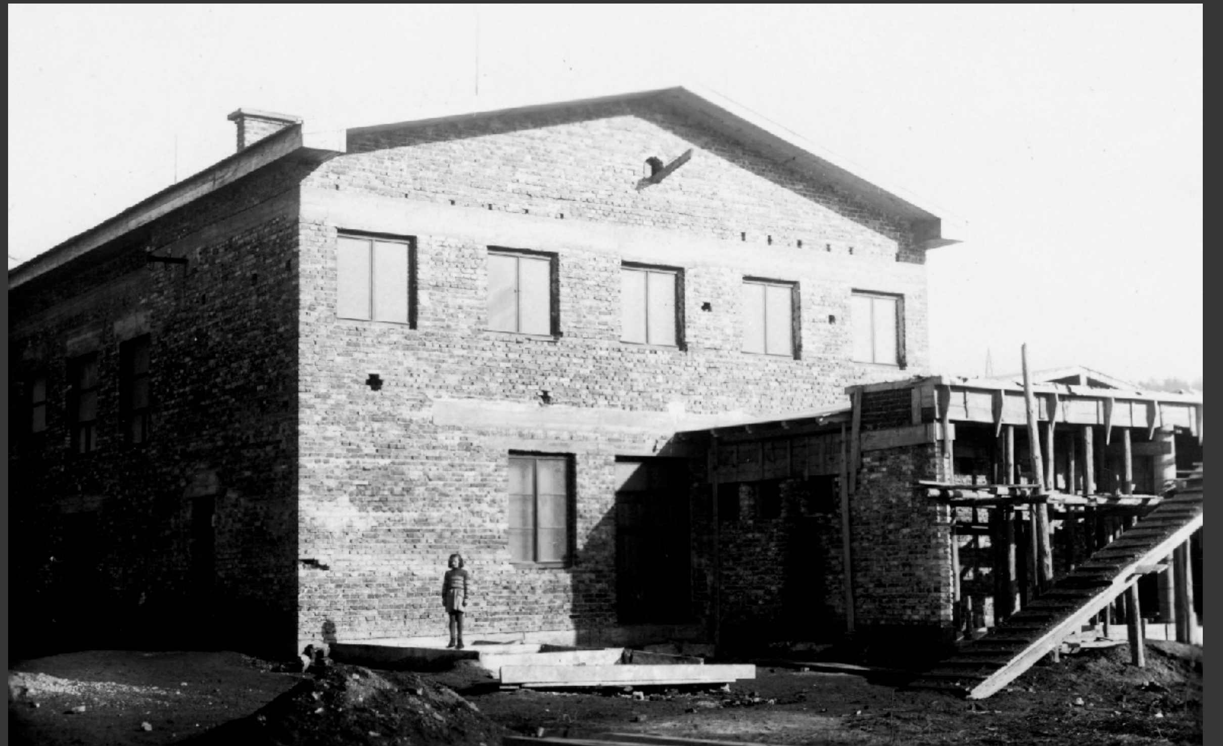
Gradnja prve dvorane
