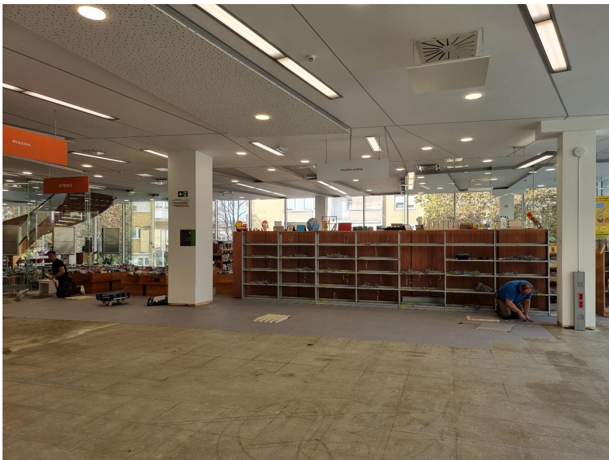
Slika 71: Obnova tal na otroškem oddelku
