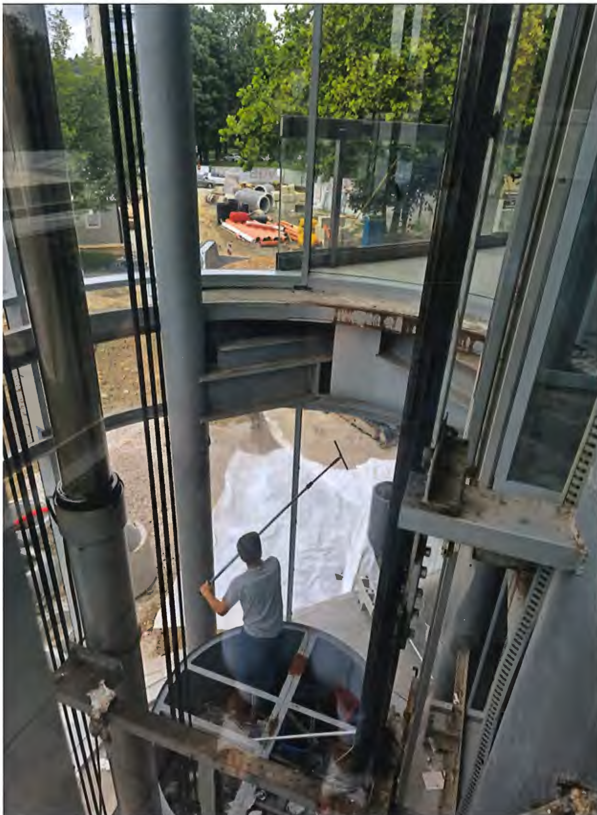
Slika 110: Čiščenje zunanjega dvigala
